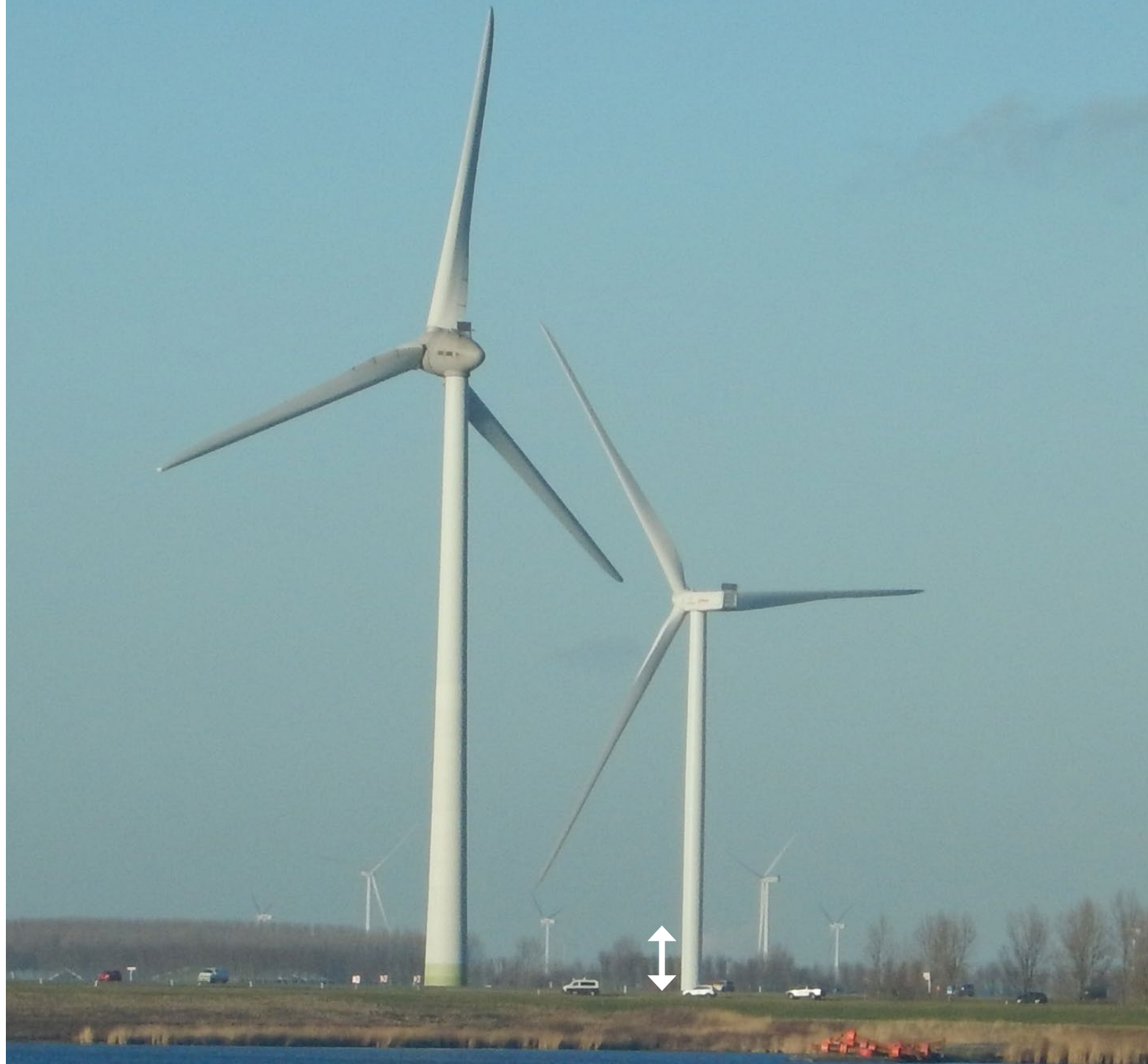
(foto J.H. van den Hamer). Rechts een tiplaagte van 20m bij een rotordiameter van 120 meter.
